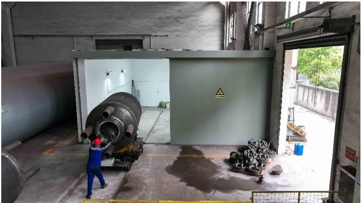
压力容器探伤房
